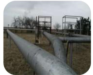
化工厂工艺管道外部防腐。所有表面在机械打磨后涂覆506环氧底胶并涂覆508防腐涂层。
