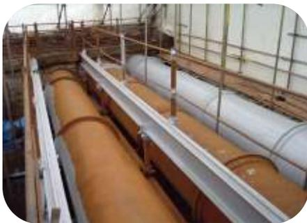
污水处理站的管道受到严重腐蚀。管道表面经机械打磨后涂覆2层506底胶涂层。
